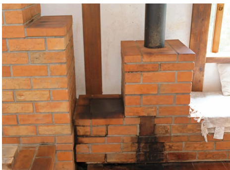
蓄熱ユニットとなるL字のヒートベンチ。煙道は水平に並ぶのではなく、上下に配されている
