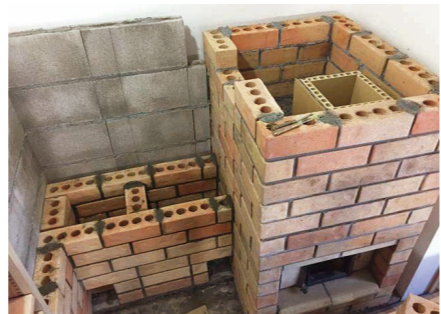
製作中の様子。右の蓄熱ユニットにはヒートライザーが見える。穴のあいたレンガはオンドル用レンガで、高温ガスをしっかり蓄熱する
