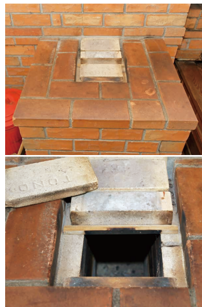
J字型の大きな燃烧ユニットに、窓際のL字のベンチを温める蓄熱ユニットが合体した巨大なロケットマスヒーター
