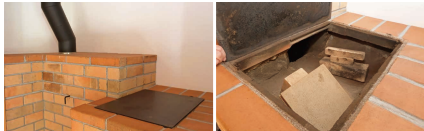
ヒートライザーを上昇したガスは天板下の空間で膨張し、壁型の蓄熱ユニットへと進む。天板は9mm厚の鉄板でカバー。蓄熱ユニットの壁にはダンパーも見える
