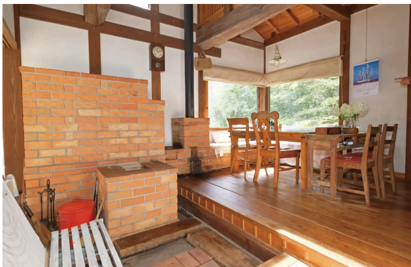
J字型の大きな燃烧ユニットに、窓際のL字のベンチを温める蓄熱ユニットが合体した巨大なロケットマスヒーター
