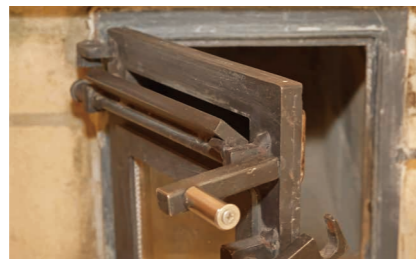
ドアの上部にはレバーで開閉できる給気口があり、これで燃焼を調整できる
