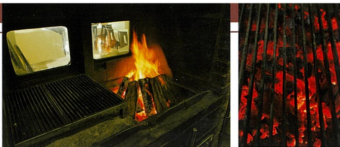
左/暖炉はイタリア産を含む5種類のレンガや粘土を用い、蓄熱性と放熱性を兼ね備えた構造。薪を焼く右側の火床を30cm掘り下げた。暖炉に風があたらないよう、空調設備も調整した。右/ロストルは高さ10cmの台に、幅0.5cm×厚さ3cmのステンレス鋼をはめ込んだもの。
